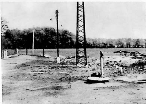
Fot. 30. Tak w 1970 r. wyglądało miejsce przyszłej budowy stadionu.
