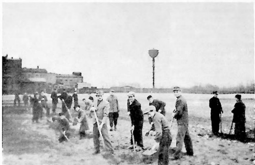
Fot. 11. Budowa boiska przy drożdżowni (1946 r.)
