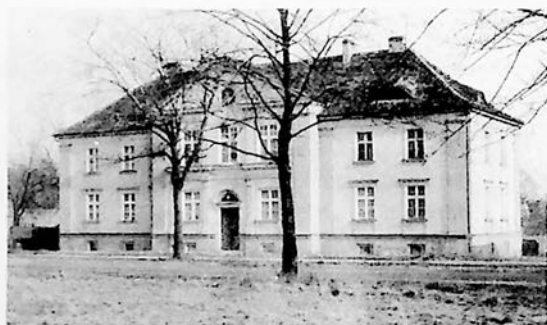
Zdjęcie 6. Dom Gminny w Luboniu - w salce na piętrze (trzy środkowe okna) odprawiano w la- tach 1933 - 1935 msze św. Na par- terze, na lewo od wejścia, istniała do 1941 r. poczta. (1992 r.)
