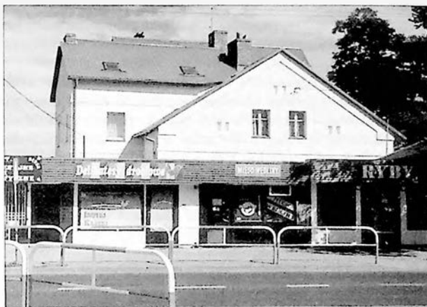
Ryc. 9. Ten sam budynek – widok od zachodu
