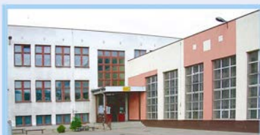
Do SP3 wchodzi się od strony bioiska (ul. Dąbrowskiego). Po prawej sala gimnastyczna służąca także gimnazjum
