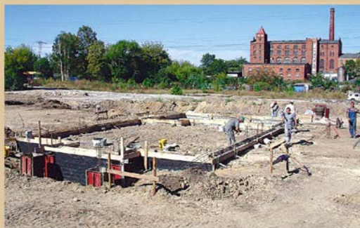
Fundamenty kaplicy z widokiem na drożdżownię
