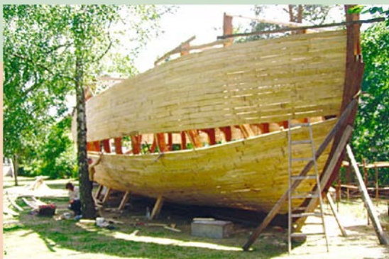
Statek Kolumba w budowie
