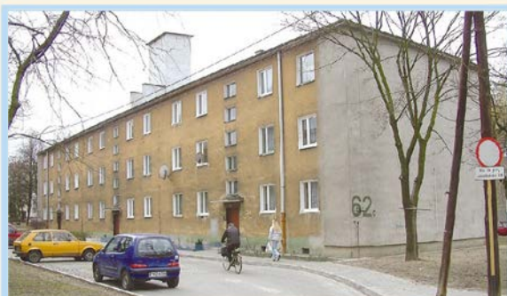
Pierwszy budynek Luboniani – 62C posiadał kotłownię, która ogrzewała powstałe kolejno w następnych latach budynki 62 D, B, E, F i A. Pionierskie bloki zaopatrywane były w wodę pochodzącą ze studni na terenie nieistniejących już dziś Zakładów Rowerowych przy ul. Powstańców Wlkp.
