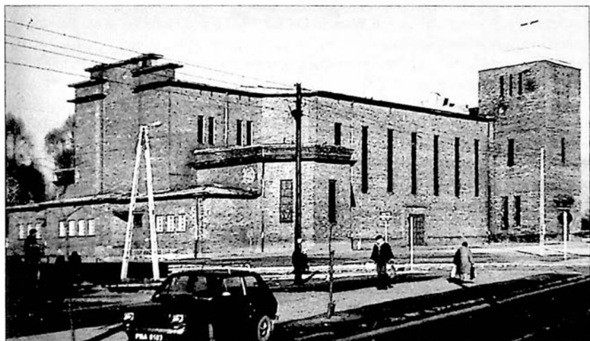
Ryc. 39. Dębica, kościół Świętej Trójcy po odbudowie wojennej. Są widoczne ślady po 25 pociskach artyleryjskich z walk w 1945 r. (stan z 1975 r.)
