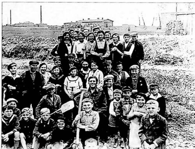
Ryc. 91. Grupa młodzieży i dzieci pracujących przy wykopach pod fundamenty kościoła św. Jana Bosko (wiosna 1936 r.). W tle z lewej strony: dwa kominy dawnej cegielni przy ul. Powstańców Wielkopolskich, pośrodku sześciorak II z 1870 r. dawnej Wyższej Szkoły Rolniczej im. Haliny w Żabikowie, rozebrany w 1999 r.
