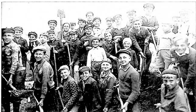
Ryc. 95. Grupa młodzieży przy pracach ziemnych podczas budowy kościoła św. Jana Bosko (lato 1936 r.)
