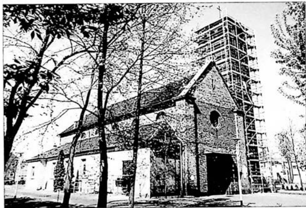
Ryc. 215. Prace tynkarskie przy kościółce św. Jana Bosko (lato 2002 r.)
