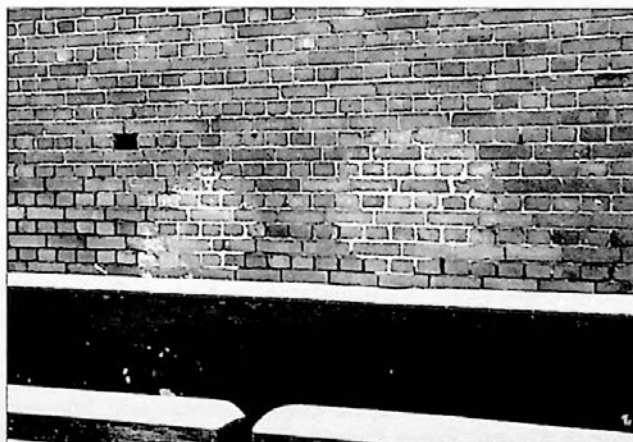
Ryc. 346. SP nr 3 – zamurowane ślady po pociskach czołgowych w ścianie południowej z walk w styczniu 1945 r. (2005 r.)
