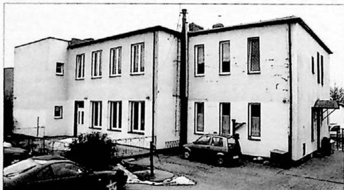
Ryc. 169. SP nr 4 – dawny budynek I z 1904 r. powiększony w 1972 r. o piętro i dodatkowe skrzydło (widoczne są dwa małe okna). Widok od strony ogrodu (2007 r.)
