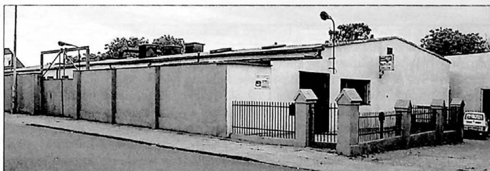
Ryc. 506. Budynek dawnego Zakładu Doskonalenia Zawodowego przy ul. Dworcowej (2006 r.)
