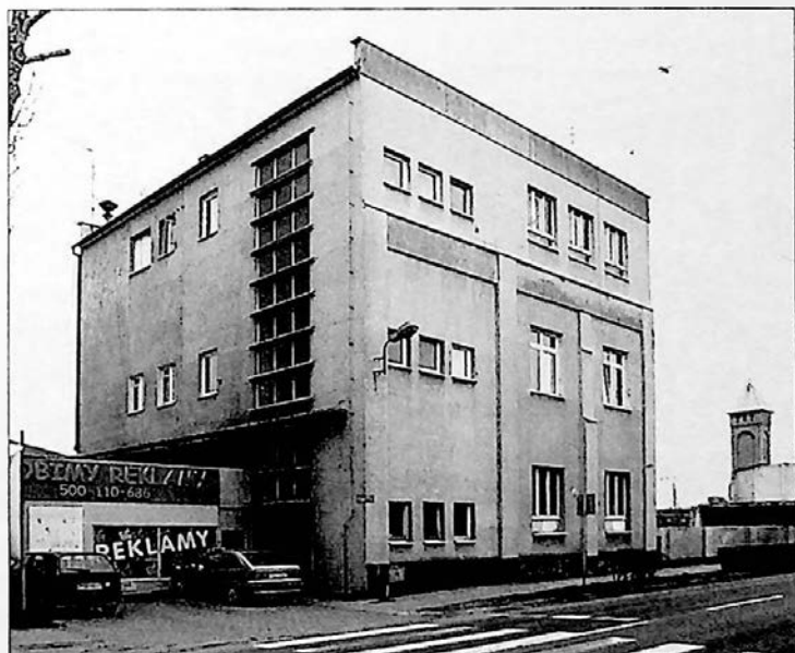
Ryc. 500. Budynek dawnej szkoły zawodowej przy ul. Armii Poznań 49b (2007 r.)
