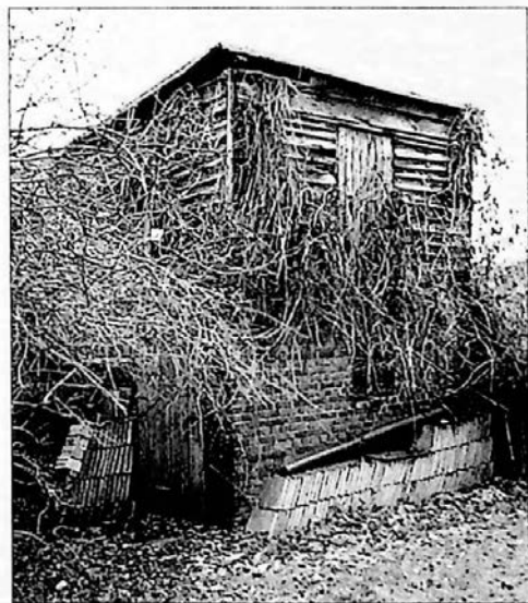
Ryc. 385. Budynek gospodarczy niemieckiego kolonisty przy ul. Kollątaja z 1910 r. (2007 r.)
