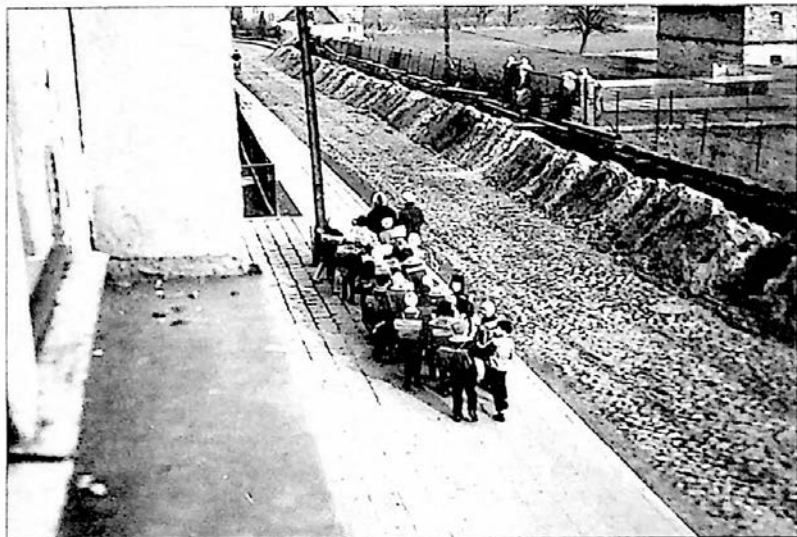
Ryc. 257. SP nr 2 – układanie wodociągu w ul. Żabikowskiej. W dali, za słupem, ostatni dom luboński pokryty słomą należący do Kubiaków (1968 r.)
