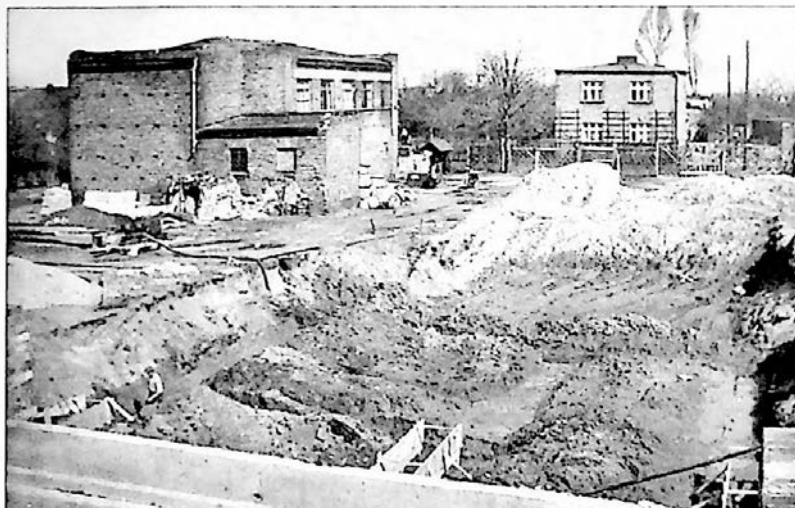
Ryc. 149. SP nr 4 – wykopy pod budynek IV. Z lewej dawny budynek Towarzystwa Gimnastycznego „Sokół” (1963 r.)
