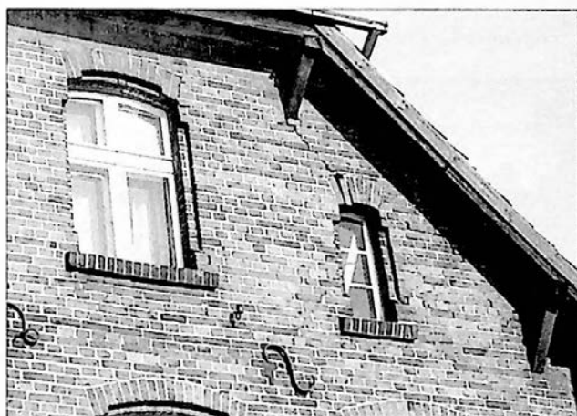
Ryc. 345. SP nr 3 – z prawej strony okien ściany południo- wej zachowały się ślady walk ze stycznia 1945 r. (2005 r.)
