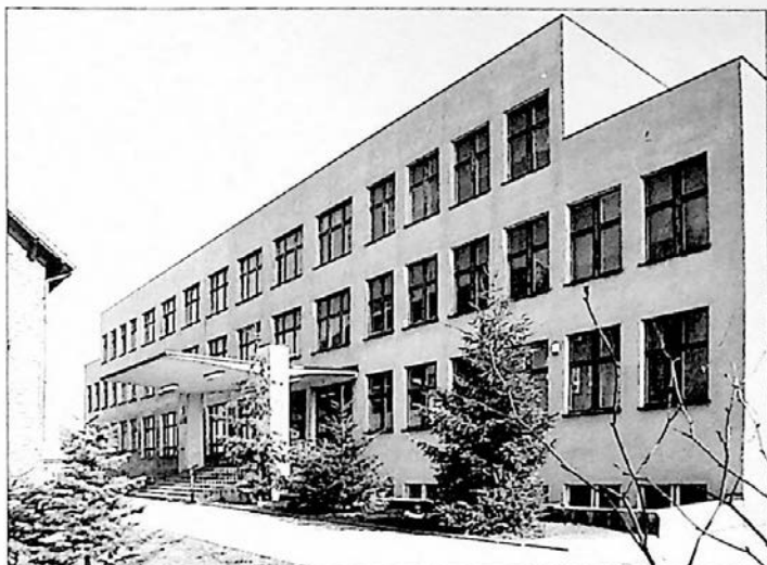
Ryc. 447. Budynek Gimnazjum nr 1 od strony wejścia (2007 r.)
