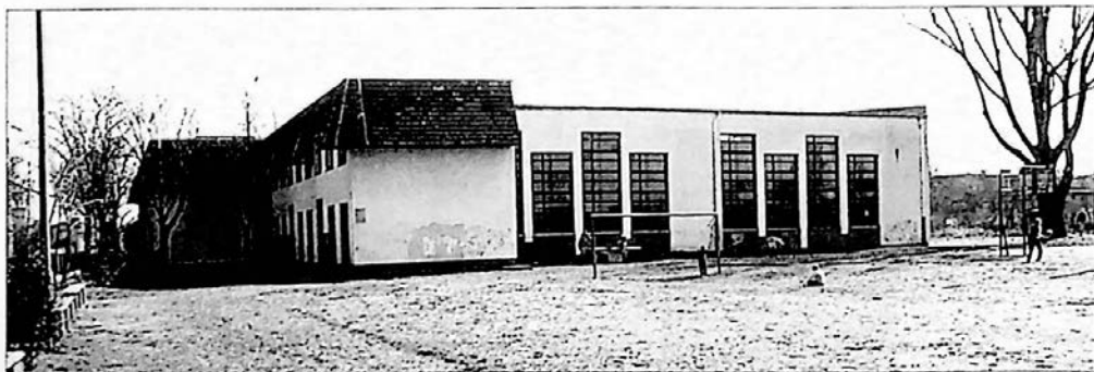
Ryc. 269. SP nr 2 – widok na salę gimnastyczną od strony boiska (2001 r.)
