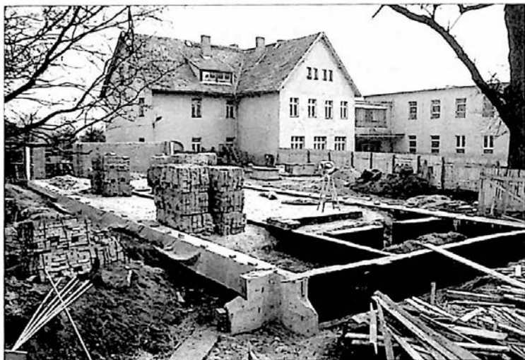
Ryc. 267. SP nr 2 – budowa skrzydła C w 1992 r. W tylnym planie budynek z 1908 r., z prawej – skrzydło B z 1961 r.
