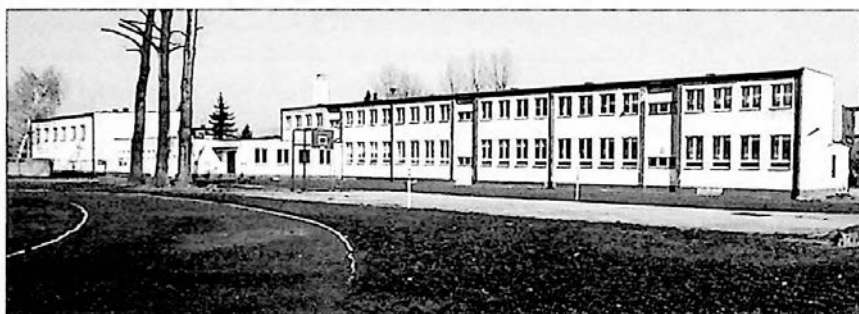
Ryc. 151. SP nr 4 – widok od strony zachodniej (2007 r.)
