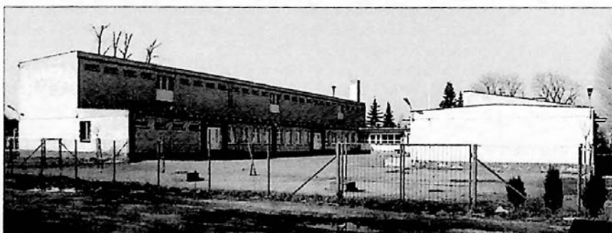
Ryc. 152. SP nr 4 – widok od strony południo- wej (2007 r.)
