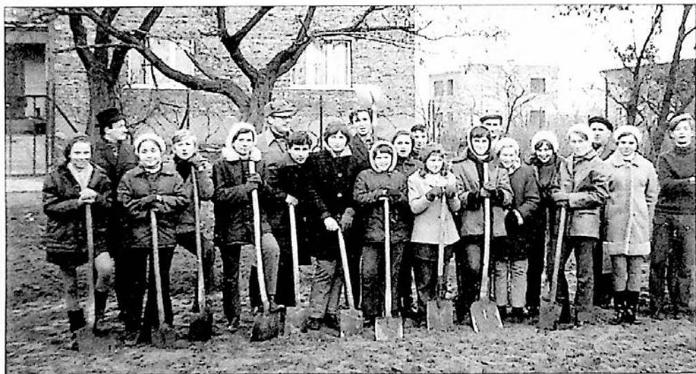
Ryc. 356. SP nr 3 – czyn społeczny przy budowie stadionu przy ul. Rzecznej (ok. 1972 r.)
