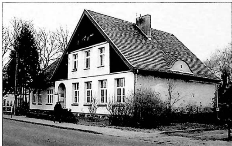
Ryc. 74. Wiry – budynek IV od strony ul. Łęczyckiej (2006 r.)
