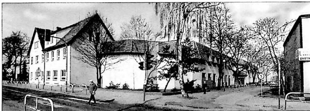
Ryc. 268. SP nr 2 – widok z ul. Żabikowskiej po rozbudowie o skrzydło C (2001 r.)
