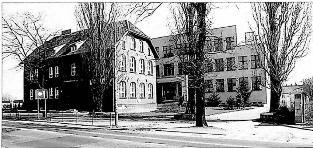
Ryc. 467. Budynek Liceum Ogólnokształcącego (dawny budynek SP nr 3), za nim budynek Gimnazjum nr 1, widok od ul. Armii Poznań (2006 r.)
