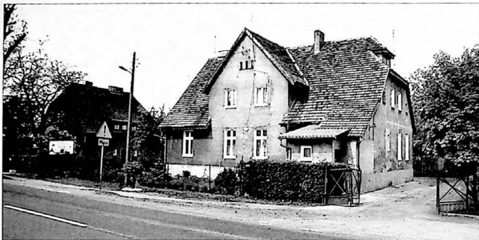
Ryc. 6. Poznań-Fabianowo – dawny budynek komisarza obwodowego przy ul. Głogowskiej (2006 r.)
