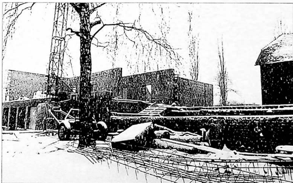
Ryc. 359. SP nr 3 – budynek II, budowa przyziemia (1985 r.)
