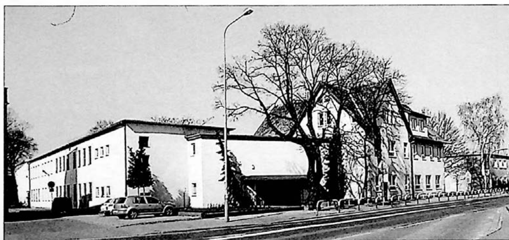
Ryc. 249. SP nr 2 – widok na szkołę od ul. Żabikowskiej (dawniej Poznańskiej), z prawej budynek z 1908 r., z lewej piętrowe skrzydło z 1961 r.
