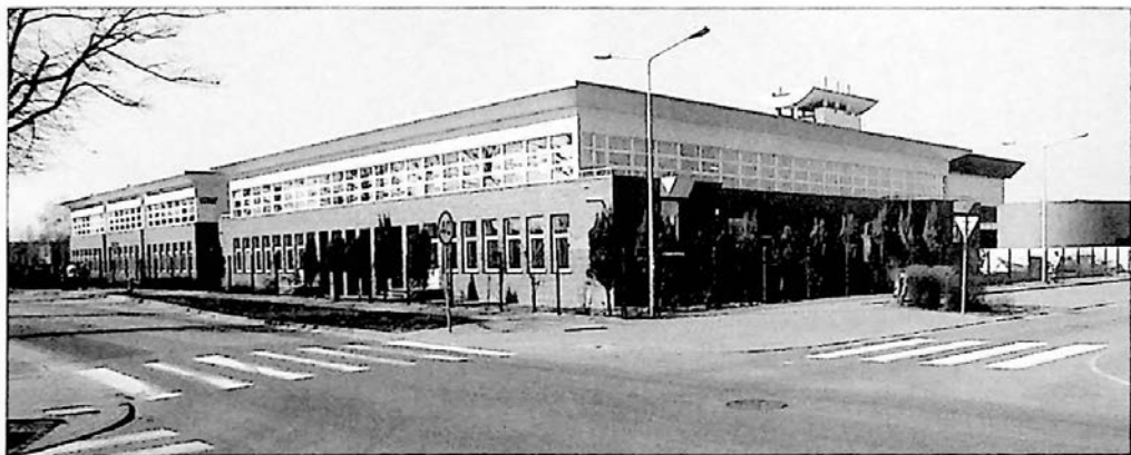
Ryc. 460. Budynek Gimnazjum nr 2 – widok od strony południowo-wschodniej z ul. Wojska Polskiego (2006 r.)
