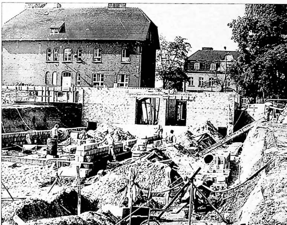
Ryc. 358. SP nr 3 – budynek II, budowa piwnic. W tle budynek I (1984 r.)
