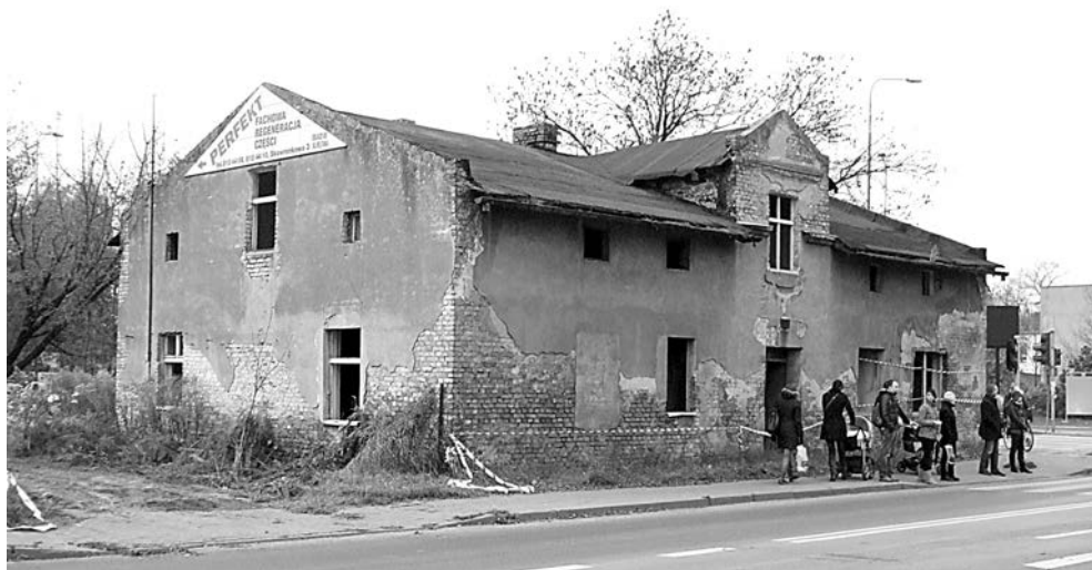
Jedno z ostatnich ujęć historycznej karczmy. Zdjęcie wykonane w przeddzień rozbiórki. Zlikwidowane płoty i krzaki pozwalają na ukazanie pełnej bryły historycznego obiektu fot. Piotr P. Ruszkowski
