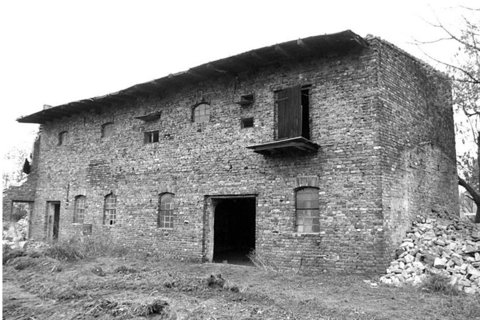
Budynek gospodarczy przy zabudowaniach karczmy, który stał wzdłuż ul. 11 Listopada, wykorzystywany przez wiele ostatnich lat na stolarnię. Widok od podwórza (strona południowa) fot. Piotr P. Ruszkowski
