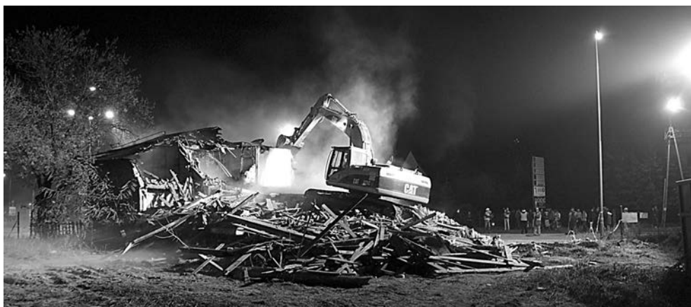
Bez trudu koparka przewraca ceglane mury związane zaprawą wapienną. Drewniane stropy i dach też nie stanowią oporu. Widok od podwórza fot. Piotr P. Ruszkowski
