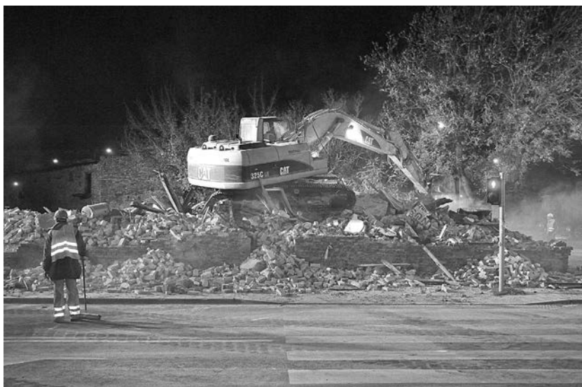
Na koniec pozostanie oddzielenie drewna i wywiezienie gruzu do kruszarni fot. Mariusz Marszałkiewicz
