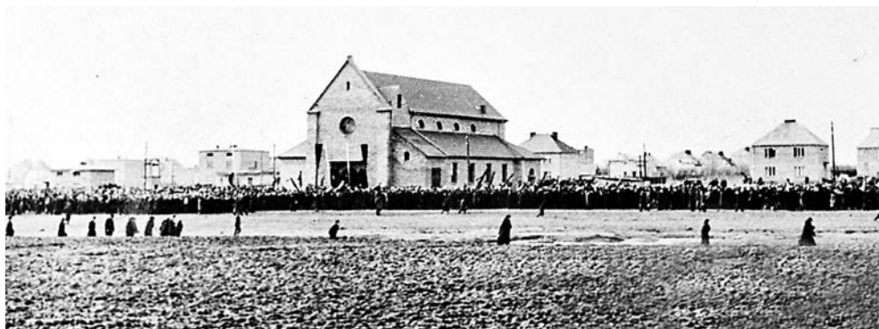
Perspektywa na nową świątynię pw. św. Jana Bosko w Luboniu z widokiem niepoliczzonego tłumu, który przed kościołem brał udział w uroczystościach pogrzebowych budowniczego i pierwszego proboszcza – ks. Stanisława Streicha. Warto też zwrócić uwagę na pierwotną bryłę kościoła – bez wieży
