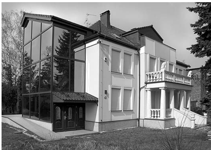
Tak wygląda obecnie dawny dom Boczoniów przy ul. Okrzei 43 fot. Piotr P. Ruszkowski
