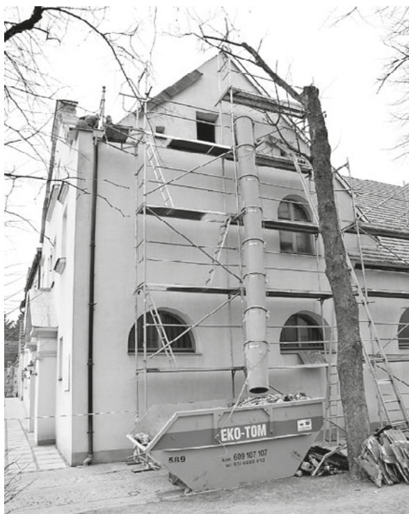
Ostatni większy remont m.in. dachu kaplicy miał miejsce w 2018 r. fot Piotr Ruszkowski
