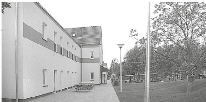
Przedszkole widziane od strony ul. Granicznej. Funkcjonalnie zaplanowany kompleks jest wyposażony w niezależne wejście, ekologiczny plac zabaw i miejsce, gdzie maluchy mogą odpocząć oraz posilić się na powietrzu. Przez duże okna na przyziemiu rodzice mogą obserwować bawiące się w salach pociechy fot. Hanna Siatka, arch. „WL”
