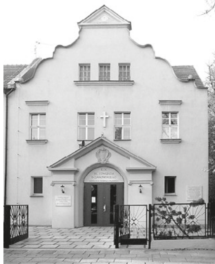
Frontowa elewacja dobudowanej w 1922 r. kaplicy w Roku bł. Edmunda Bojanowskiego – 2014 fot. Hanna Siatka, arch. „WL”
