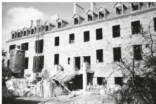
Budowa Ochronki i Domu Rekolekcyjnego idzie całą parą – stan z września 1990 r. fot. arch. Sióstr Służebniczek M.
