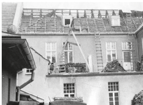
Z uszkodzonej pożarem części dachu zdjęto dachówki i przystąpiono do wymiany więźby dachowej fot. arch. Sióstr Służebniczek M.
