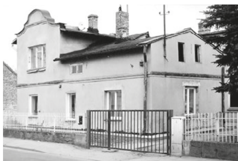
Dom rodowy Trittów przy ul. 3 Maja 19 (przed wojną ul. Remleina 9) to tutaj w dobudowanej z tyłu części, łączącej z frontowym domem oszklonym tunelem na piętrze Alojzy miał przed wojną zakład elektrotechniczny
