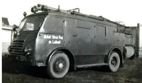
Strażacki wóz bojowy dla Ochotniczej Straży Pożarnej miasta Luboń. GM 8 – gaśniczy Star A20, wyposażony w silnik benzynowy, rzędowy, 6-cylindrowy S42; moc: 85 KM; długość: 5,86 m, szerokość i wysokość: 2,2 m; masa: 3 360 kg. Pojazd nie miał fabrycznie wbudowanego zbiornika wodnego, posiadał motopompę o wydajności 800 l/min.
