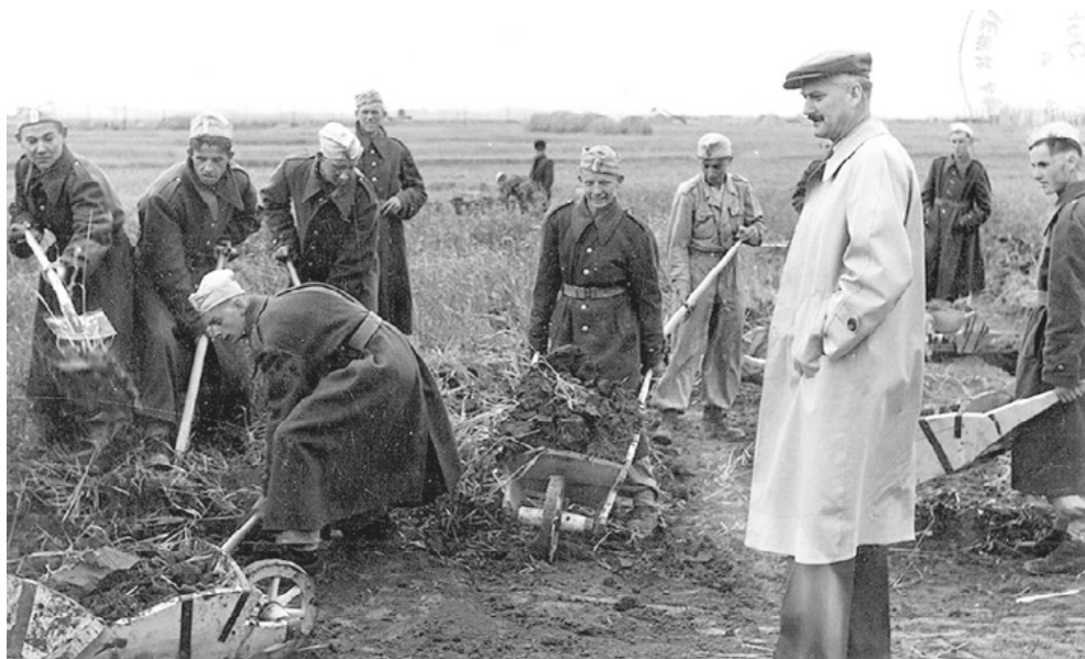
Rozpoczęcie prac przy wykopach pod fundament wielkiego pieca nr 1 (16.05.1952 r.). W jasnym płaszczu dyrektor naczelny huty – inż. Jan Anioła podczas rozmowy z junakami Służba Polsce (SP)*. ze zbiorów Archiwum Narodowego w Krakowie https://ank.gov.pl/ [dostęp 30.11.2020 r.]
