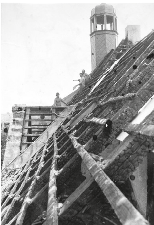
Zwglona konstrukcja dachu budynku zakupionego przez siostry w 1920 roku fot. arch. Sióstr Służebniczek M.
